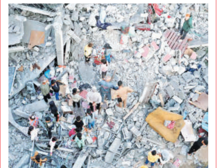
गाजा के खान युनुस बाजार में इजरायली हमले में क्षतिग्रस्त एक घर का निरीक्षण करते हुए फिलिस्तीनी।
